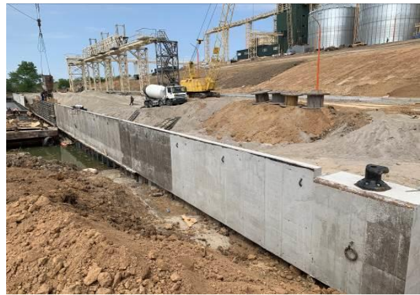
Рис. 1. Загальний вид причальної стінки
