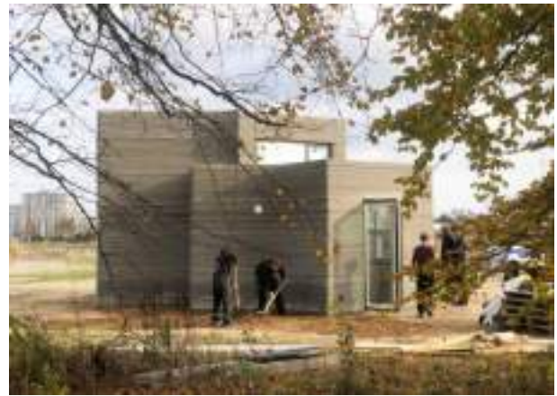
Рис.1. Житловий будинок, роздрукований на 3-D принтері, Данія
